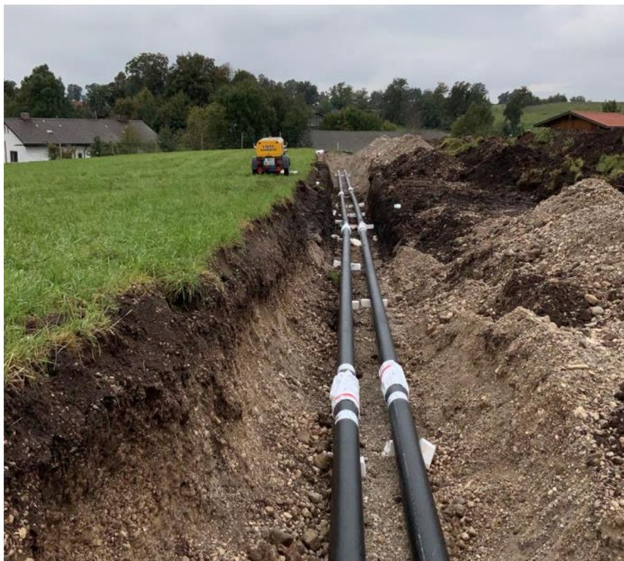
Rohre zur Fernwärmeversorgung werden verlegt (Foto: MW Biomasse)
